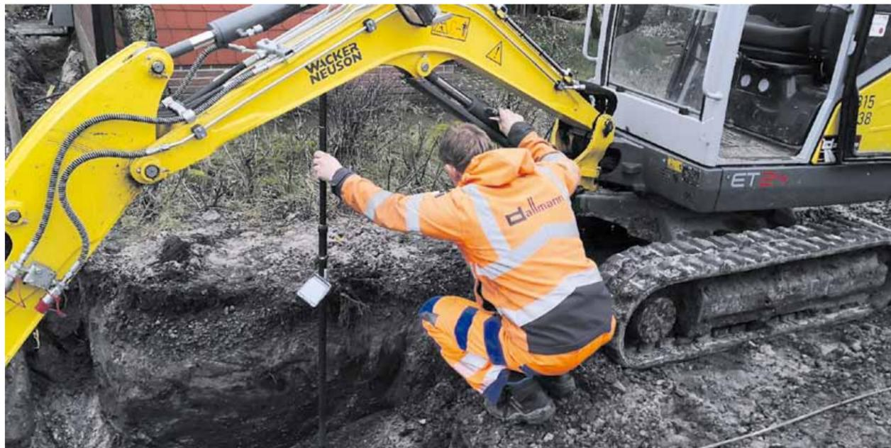
Aufmaß einer Schelle mit Smartphone und Softwareunterstützung in einem Rohrgraben.
